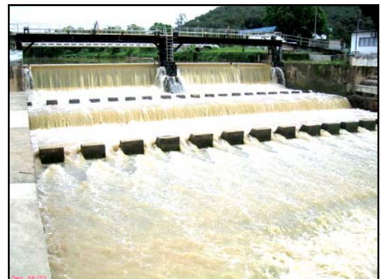
SG. LINGGI WEIR GATES
